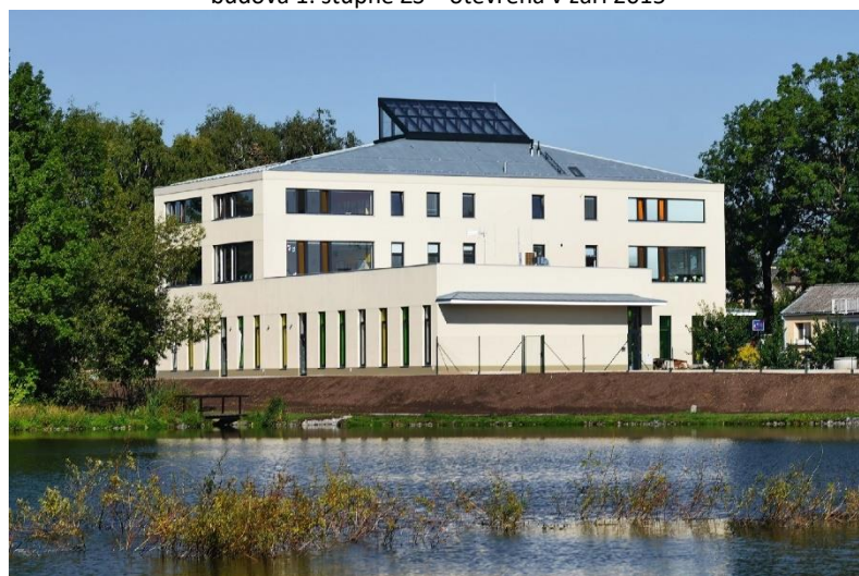
budova 2. stupně ZŠ – otevřena v září 2017
